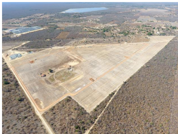
BJL 4 Solar en construction (PC: Biosar)
