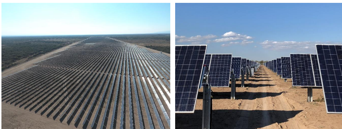
La Planta Solar « Caldenes del Oeste »
